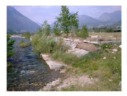
Figura 16. Terminazione sud dell'attuale difesa arginale del rilevato di pista. Il grado di efficacia idraulica per la funzione di contenimento delle piene circa centenarie da parte della struttura è oggi da verificare in relazione alla consistenza e alla morfologia del deposito in alveo
